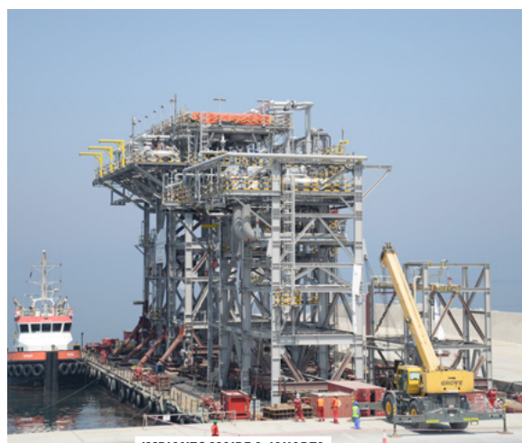
IMPIANTO MAIRE A JAKARTA
